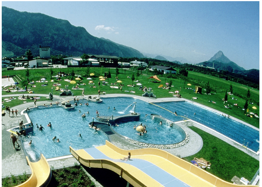
Image 1: Assemblage de plusieurs bassins
